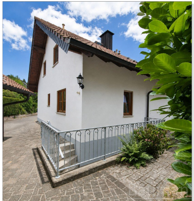
Zugang zum Keller Einfamilienhaus Unkel Scheuren
