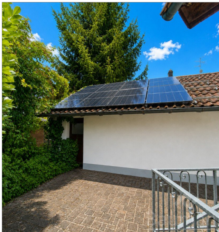
Garage mit eigener PV-Anlage Einfamilienhaus Unkel Scheuren
