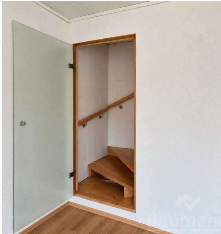
Zugang zum Dachboden - Einfamilienhaus in Bad Hönningen (*)
