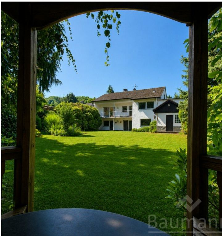
Aussicht aus dem Pavillon Einfamilienhaus Bad Hönningen
