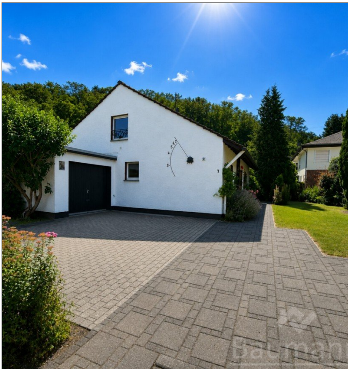
Einfahrt zur Garage Einfamilienhaus Bad Hönningen
